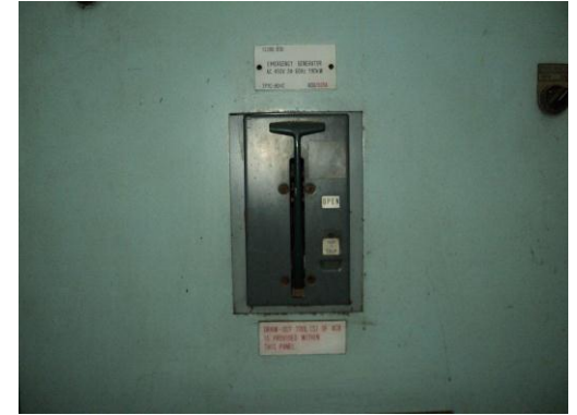
Выключатель старого типа АН16В в панели
